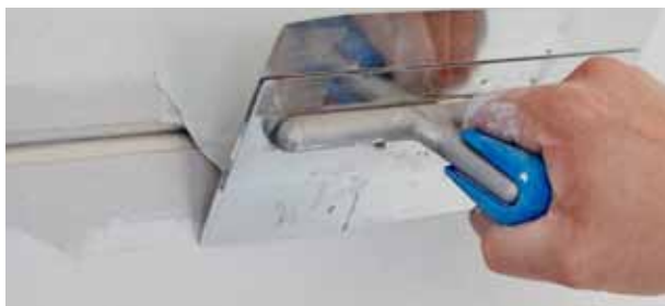
Ausdrücken der Querfugen mit Fugenfüller.
