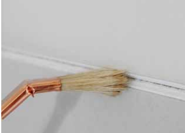
Gipsstaubentfernung für eine gute Haftung!
