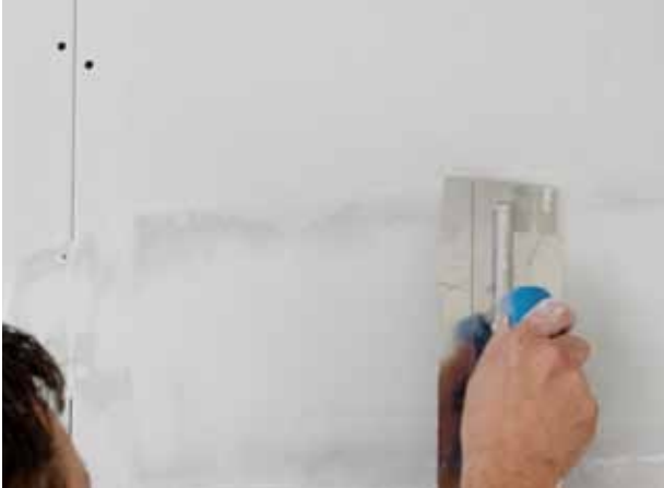
Überziehen des Rigips-Bewehrungsstreifens ohne zusätzlichen Materialauftrag.
