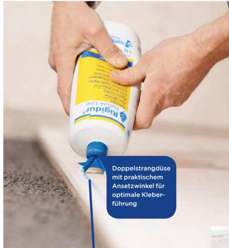
Doppelstrangdüse mit praktischem Ansetzwinkel für optimale Kleberführung
