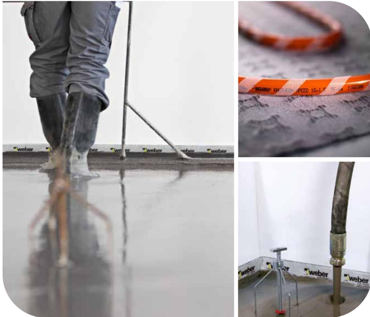
Beim Ausgleich von Unebenheiten, zur Einbettung von Rohren und Heizungssystemen sowie zur Überarbeitung schwieriger Untergründe wie Holzdielen oder Asphalt, leisten Ihnen unsere Ausgleichsmassen wertvolle Dienste. Eine besondere Herausforderung für jeden Bodenleger ist die Sanierung im laufenden Betrieb. Ob im Verbund oder als schwimmende Konstruktion, unsere schnell belegbaren Produkte sparen Ihnen dabei wertvolle Zeit.
