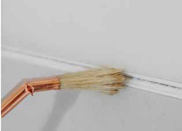
Gipsstaubentfernung für eine gute Haftung!
