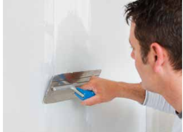
Die Nachspachtelung erfolgt erst nach dem Abbinden der Vorspachtelung.
