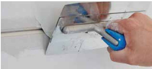
Ausdrücken der Querfugen mit Fugenfüller.
