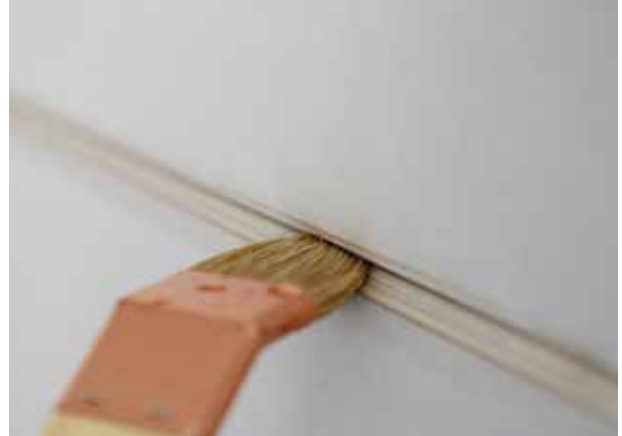
Das Vornässen der Querkante ist wichtig, damit der Spachtelmasse nicht zu schnell das Wasser entzogen wird.
