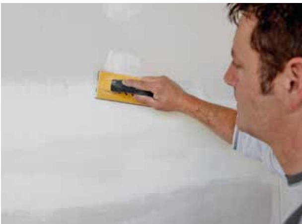
Nach kompletter Durchtrocknung des Spachtelmaterials kann die Oberfläche geschliffen werden.
