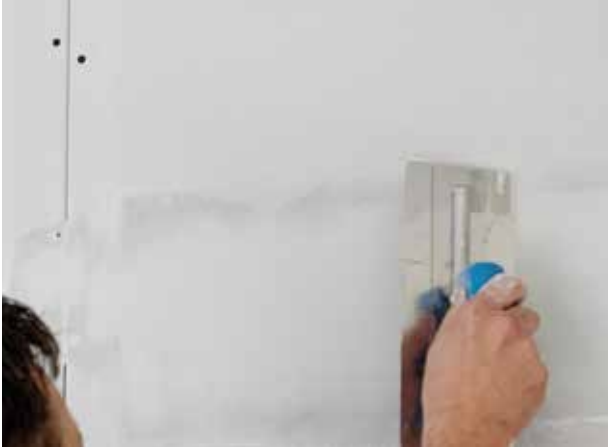
Überziehen des Rigips-Bewehrungsstreifens ohne zusätzlichen Materialauftrag.
