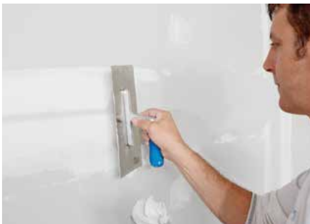
Vorlegen des 1 mm dicken Spachtelbettes.
