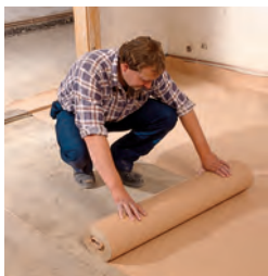
Ausrollen der Rieselschutzbahn
