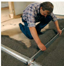
Abziehen der Rigips Ausgleichsschüttung
