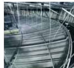
Montiert auf der Baustelle
