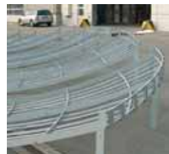
Die Unterkonstruktion wird zerlegt
