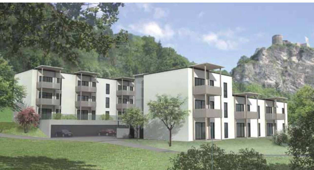
Das Öko-Vorzeigeprojekt GRIFFEN GREEN ist mit 18 Wohneinheiten der erste Sozialwohnbau Kärntens in Holzbauweise.
